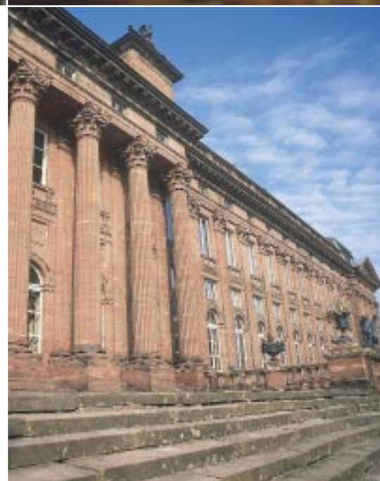
Château des Rohan à Saverne : résidence épiscopale du 18 ème siècle
