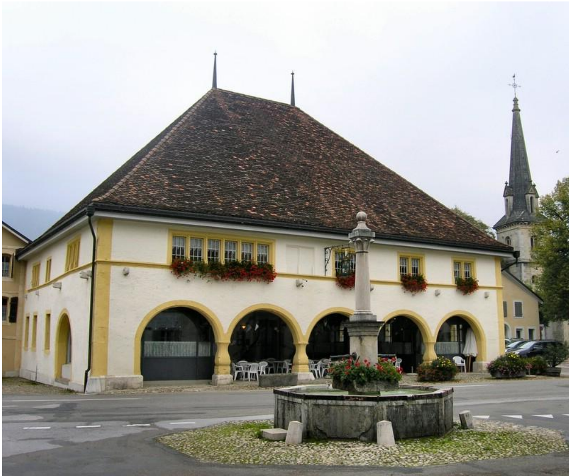
Une fontaine de Môtiers (Val-de-Travers), devant la halle au marché. A-t-elle été étanchéifiée au ciment d'asphalte du Val-de Travers ?
